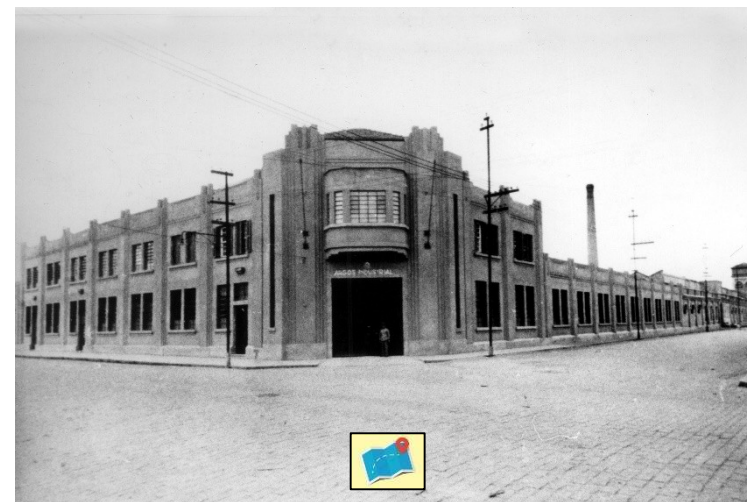
Esquina da Argos entre as ruas Dr. Cavalcanti e José Do Patrocínio
