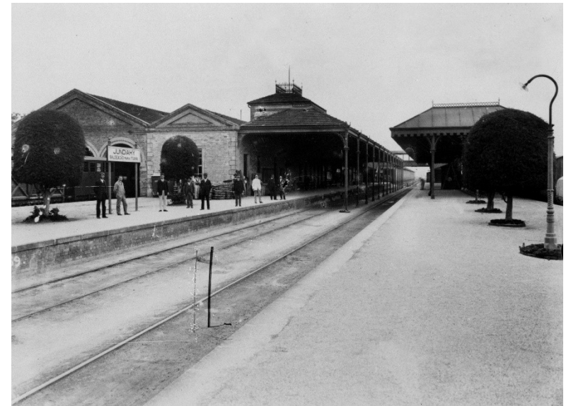
Vista interna da estação
