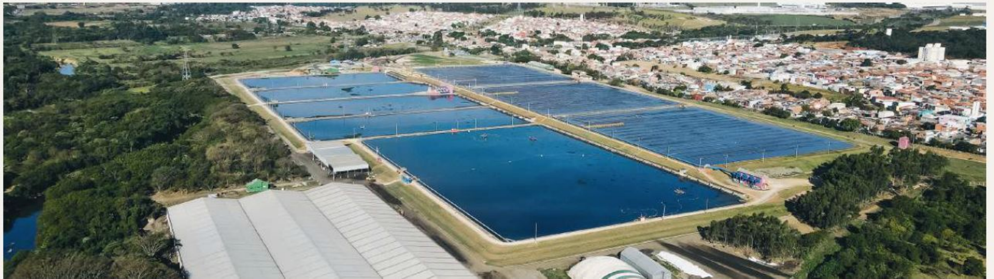
Estação de Tratamento de Esgoto de Jundiaí - ETEJ
