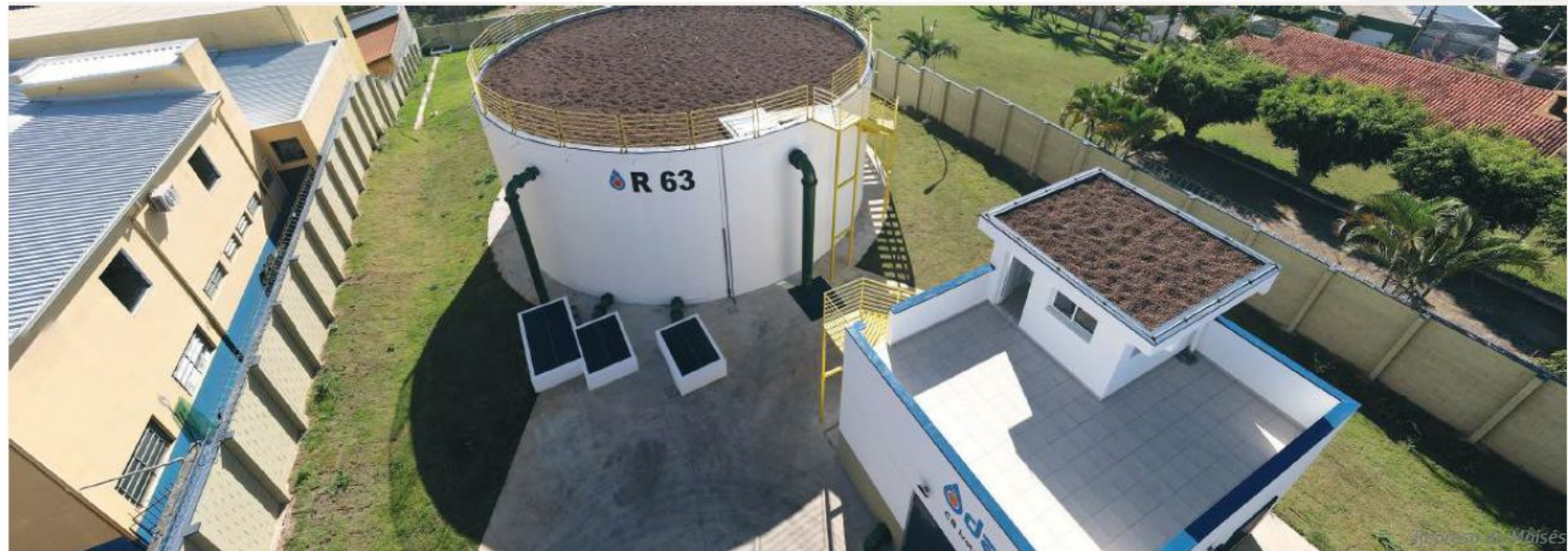
Reservatório de água tratada do Ivoturucaia
